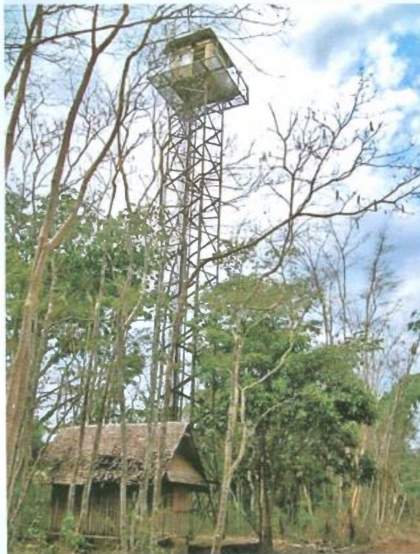
Mirador de 25 mètres de haut pour la surveillance des feux de végétation. Photo A. Hounkpèvi.
